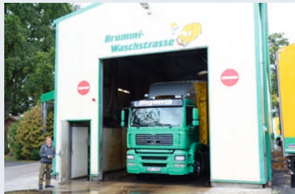
Das Wasser der Waschanlage wird durch Mikroorganismen gereinigt und wiederverwertet
